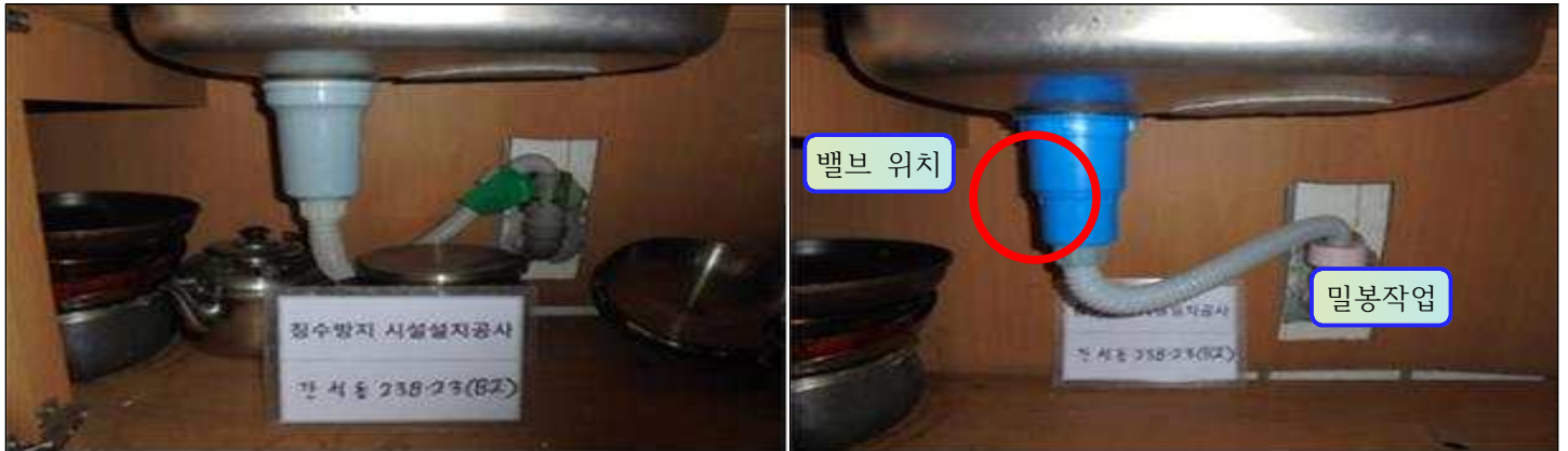
역류밸브 싱크대 시공(전)
